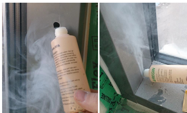
Figur 2. Luftläckage i partikonstruktion. (Egen bild)
